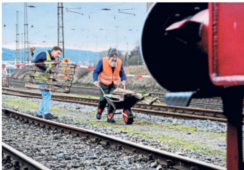
Nachschub her: Schubkarrenweise müssen die passend gesägten Holzbalken herbeigeschafft und ins Feuerloch bugsiert werden.
